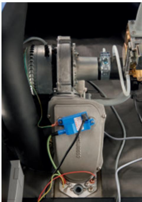
Nella figura soprastante è possibile vedere come si presenta la caldaia VARMAX nella parte bruciatore. Con una semplice chiave a brugola è possibile aprire i sei fissaggi ed aprire il coperchio di protezione della parte superiore del bruciatore per potervi accedere senza toccare e smontare organi di vitale importanza per il generatore. Con questa semplice operazione
