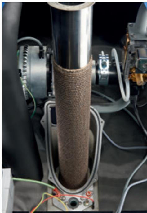
si ha la possibilità di estrarre in tutta sicurezza la struttura radiante del bruciatore per permettere una pulizia veloce ed approfondita di tutta la superficie. La superficie radiante del bruciatore è possibile lavarla con semplice acqua, anche a questo abbiamo pensato al Vostro massimo risparmio per arrivare ad avere risultati di funzionamento eccezionali.
